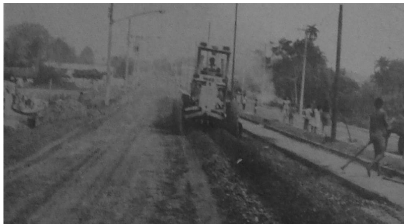
Foto 7 - Prolongamento e preparação para pavimentação da Avenida Barão do Rio Branco.
